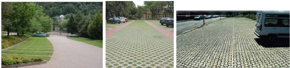
Figura 34 - Esempi di pavimentazioni permeabili
