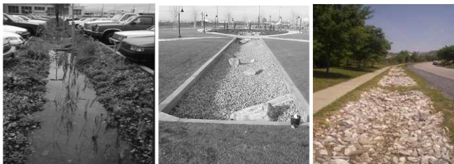
Figura 28 – Esempi di trincee d’infiltrazione
