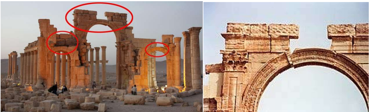
Palmyra, archi romani da restaurare, oggi
